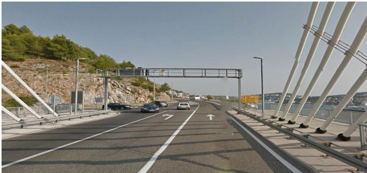
Slika 16. Početak rekonstrukcije dionice D8 u gradu Dubrovniku-izlaz s mosta F.Tuđmana-km 0+000,00
